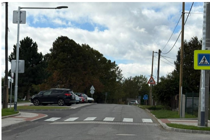
Nový osvětlený přechod pro chodce u ZŠ
