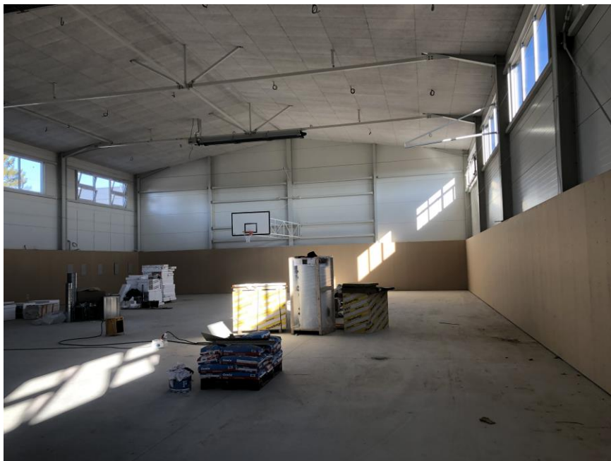
Probíhající výstavba tělocvičny u ZŠ
